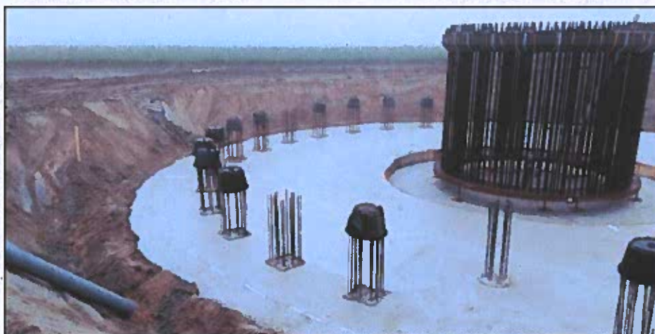
Figuur 3.2 Ankerkooi en wapeningsstaal heipalen
