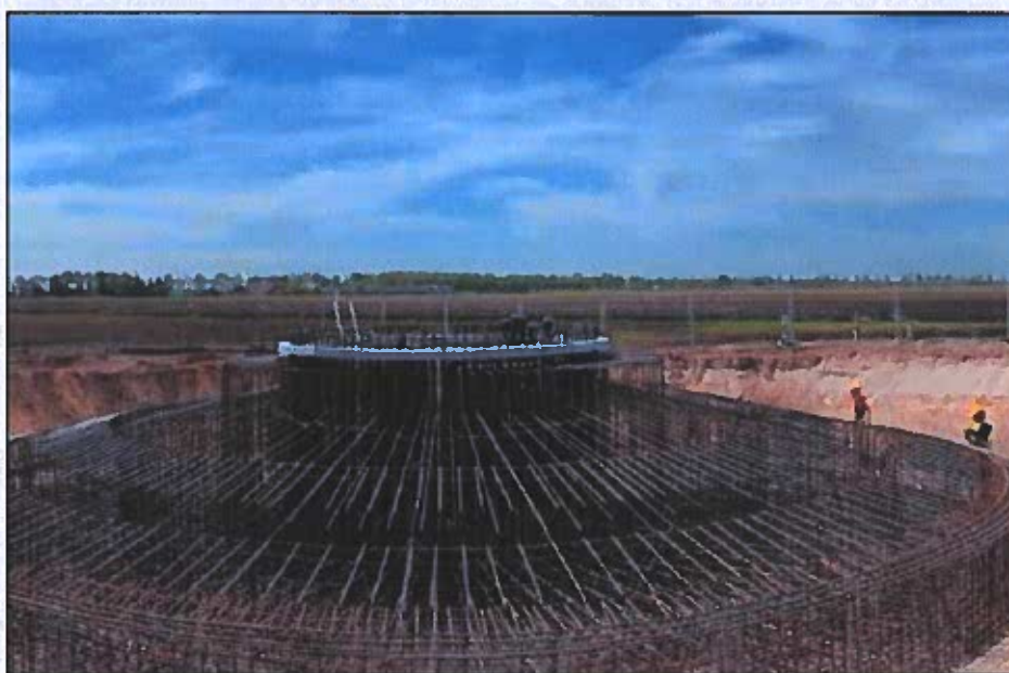
Figuur 3.3 Wapening van fundament
