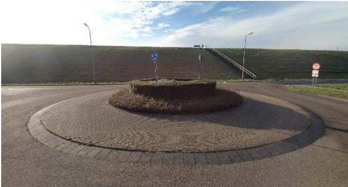
Hansweert: Rotonde kruising Boomdijk – Zeedijk – Werfdijk
